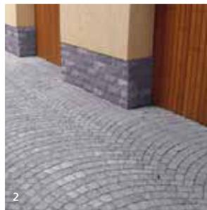
Im Trend liegen versickerungsfähige Pflasterbeläge, mit denen sich Flächen befestigen lassen, ohne sie zu versiegeln. Die Entwässerung kann dabei über die Fugen oder die Beläge selbst erfolgen. Solche „Ökobeläge“ gibt es in Form sogenannter Porenbetonsteine, bei denen das Oberflächenwasser durch den Stein hindurch im Erdreich versickert.
