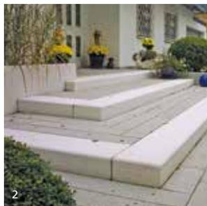
Neue Betontechnologien ermöglichen auch hier den Einsatz immer dünnerer und damit leichter Materialien. So gibt es mittlerweile nicht nur Blockstufen, deren Gewicht um die Hälfte reduziert werden konnte, sondern auch Winkelstufen in einer Dicke von nur noch zwei Zentimetern. Diese lassen sich wesentlich leichter trans-
