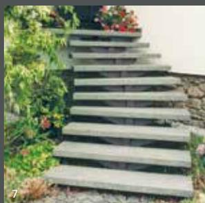
portieren und verlegen. Deshalb eignen sie sich speziell zur Sanierung alter Treppenbeläge, da sie einfach auf den vorhandenen Stufen verlegt werden können.
